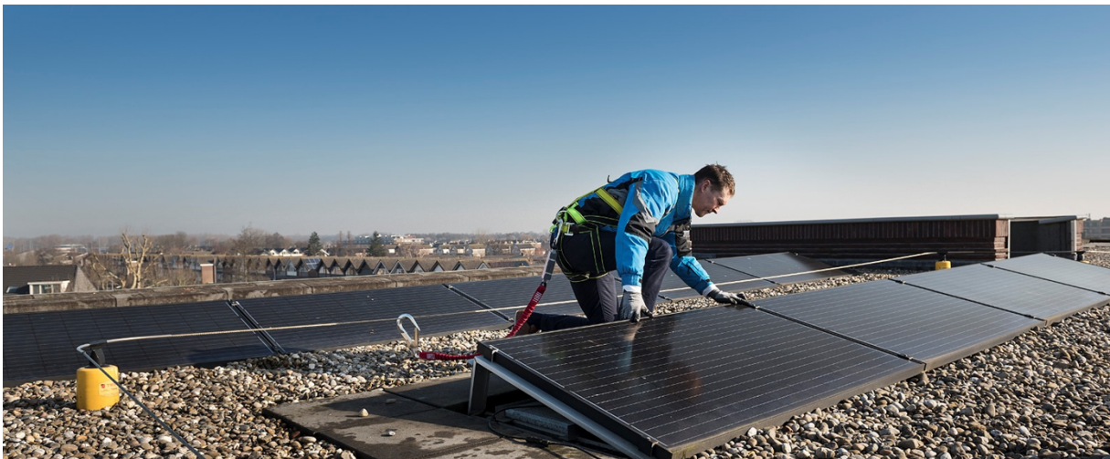
Zonnepanelen plaatsen i.c.m. renovatie van de dakbedekking (werk met werk, natuurlijke momenten)
