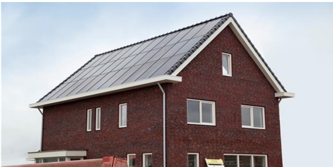
Zonnepanelen geïntegreerd in dakbedekking (werk met werk, natuurlijke momenten)
