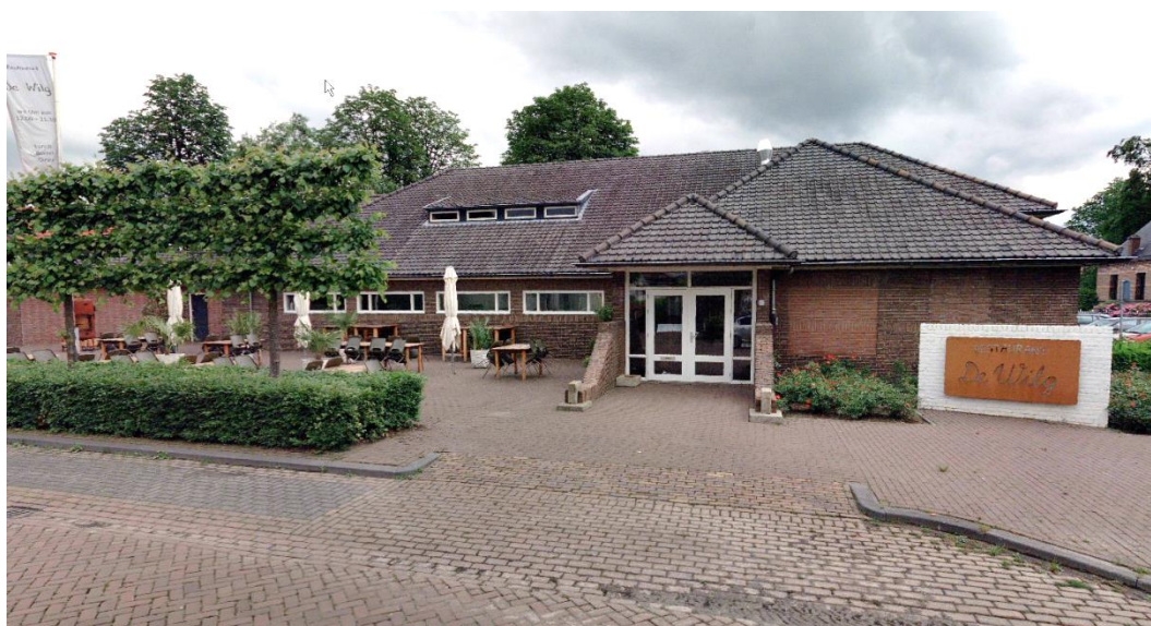
De Wilg, voorbeeld van een pand in verkoop waar onderhoud op gepleegd wordt
