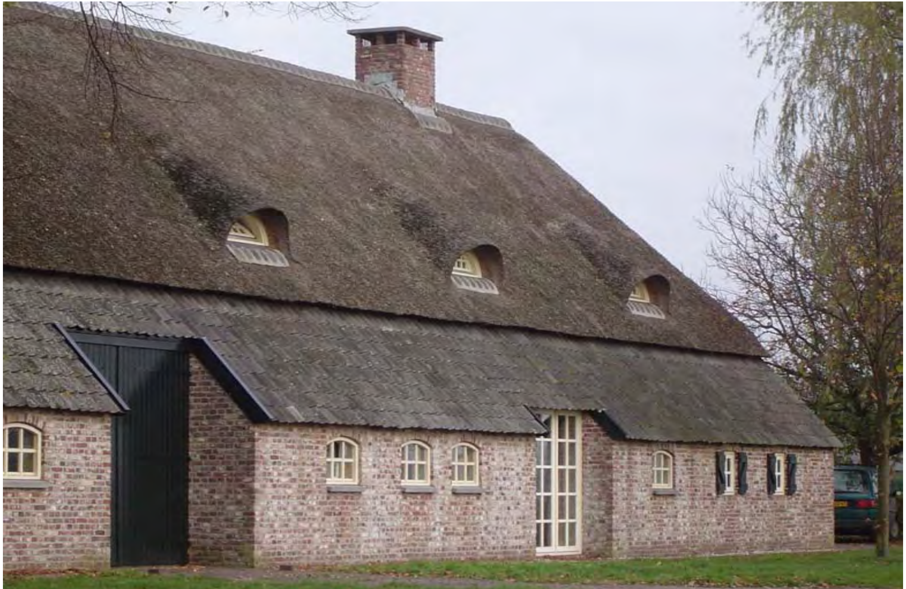
^ boerderij met rieten kap + dakcapellen + lage gootlijn
